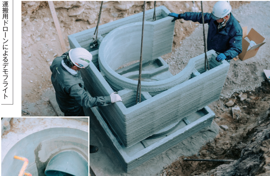
分割して製作した部材を現場で組み立てた
